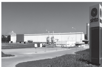
アチバイア工場全景
