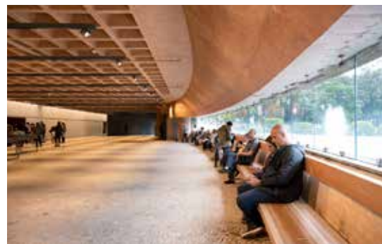
▲増築されたエントランスホール
