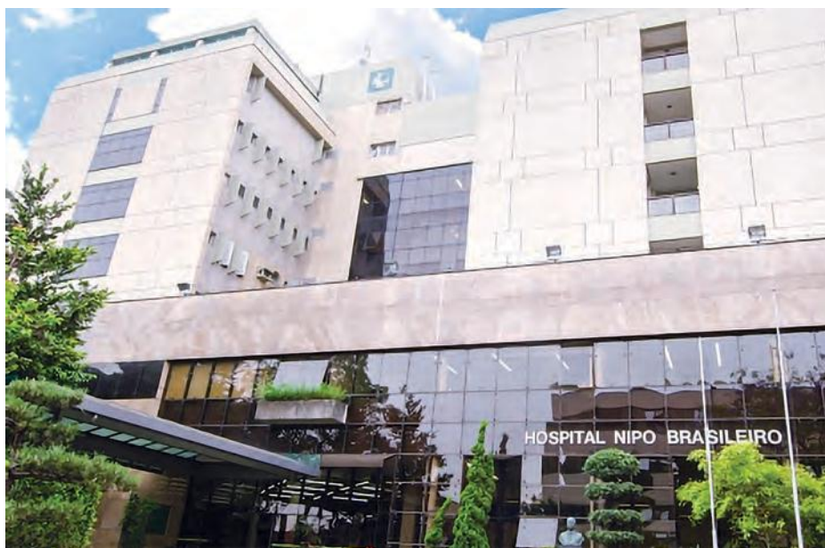
Enkyo - Hospital Nipo-Brasileiro (Sede Guarulhos)
